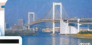
臨海部の副都心部と都心とを結び首都高11号一般の道路・新交通ゆりかもめが通る全長798mの吊り橋です。東京のウォーターフロントを代表する風景を作り出しています。
